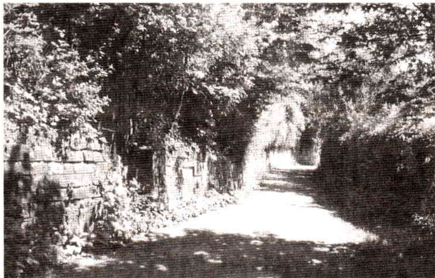
Erhaltungswürdig: die Trockenmauern entlang der Gäubahnstrecke
